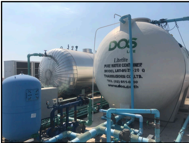
ถังเก็บน้ำชั้นดาดฟ้าขนาดความจุ 49 ลูกบาศก์เมตร
