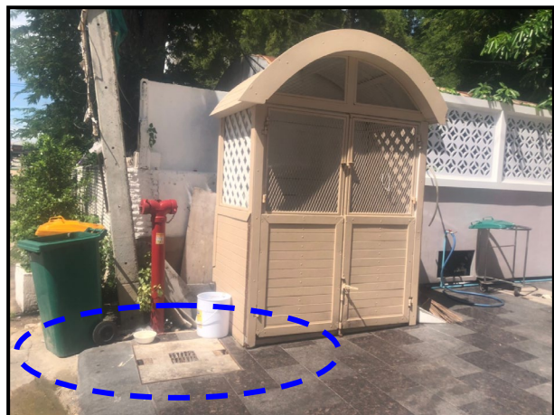
จุดที่ 1 บ่อตรวจสอบคุณภาพน้ำทิ้งก่อนระบายลงสู่ท่อระบายน้ำสาธารณะ
