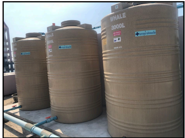
ถังเก็บน้ำชั้นดาดฟ้าขนาดความจุ 49 ลูกบาศก์เมตร
