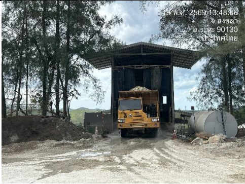
รูป 9 การปิดคลุมปากโม้มแรก
