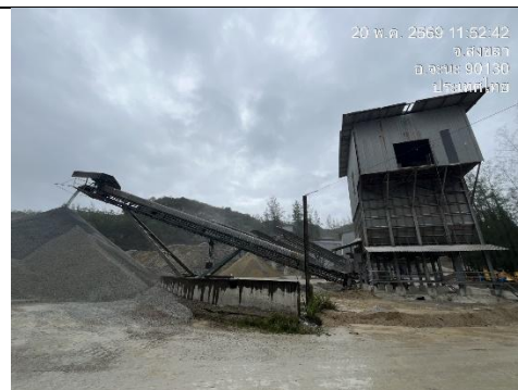
รูป 16 การปิดคลุม เครื่องบดชุดที่ 1 และ 2 และชุดตะแกรง
