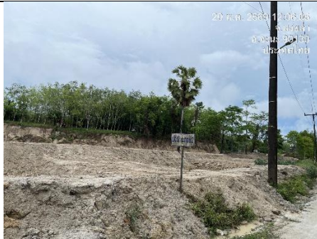
รูป 5 บ่อดักตะกอน
