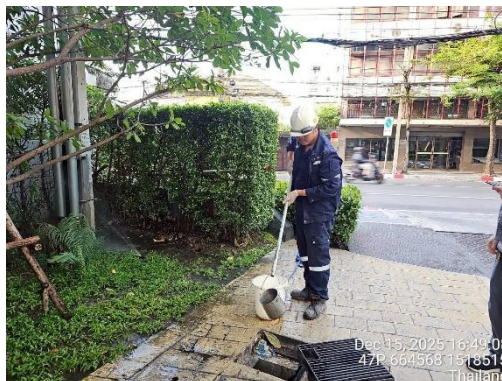
บ่อพักน้ำสุดท้ายของระบบระบายน้ำบริเวณด้านหน้าโครงการ
