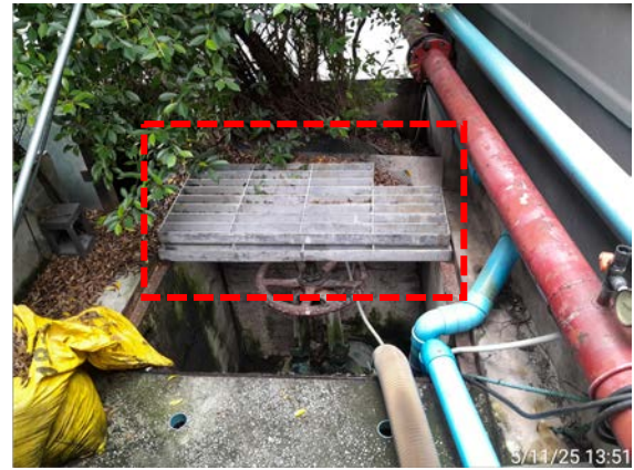
รูปที่ 2-26 ตะแกรงดักมูลฝอยบริเวณบ่อพักน้ำ
