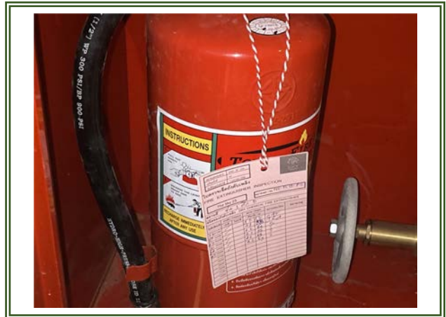
รูปที่ 2-83 ตรวจสอบถังดับเพลิง
