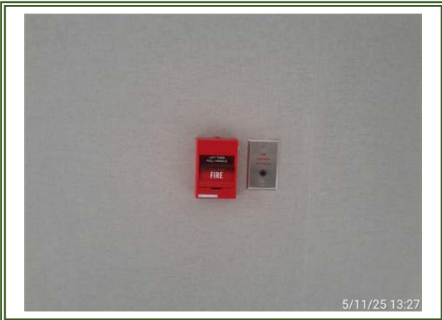
รูปที่ 2-74 อุปกรณ์แจ้งเหตุเพลิงไหม้ (Switch Board)
