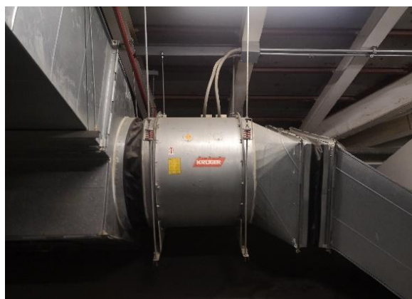
รูปที่ 3-22 ระบบระบายอากาศสำหรับบันไดหนีไฟและลิฟต์ดับเพลิง
