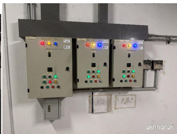
รูปที่ 3-22 ระบบระบายอากาศสำหรับบันไดหนีไฟและลิฟต์ดับเพลิง
