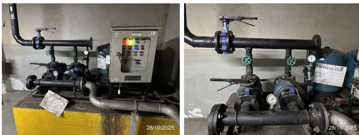
รูปที่ 2-5 เครื่องสูบน้ำหมุนเวียนกลับมาใช้ใหม่และถังเก็บน้ำหมุนเวียนกลับมาใช้ใหม่
