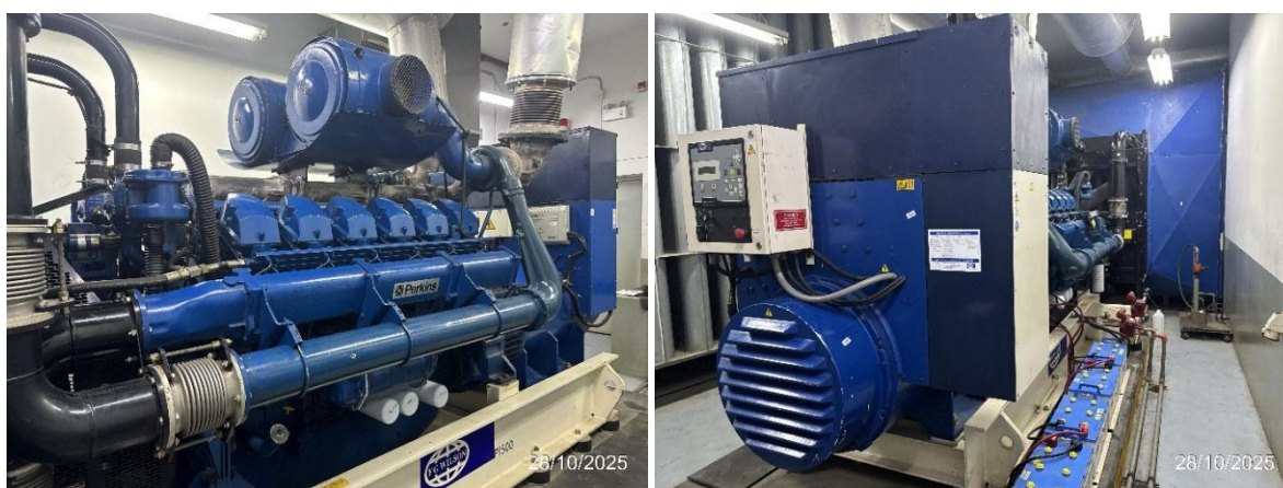
รูปที่ 2-9 เครื่องกำเนิดไฟฟ้าฉุกเฉินโดยเครื่องยนต์ดีเซล ขนาด 1500 KVA
