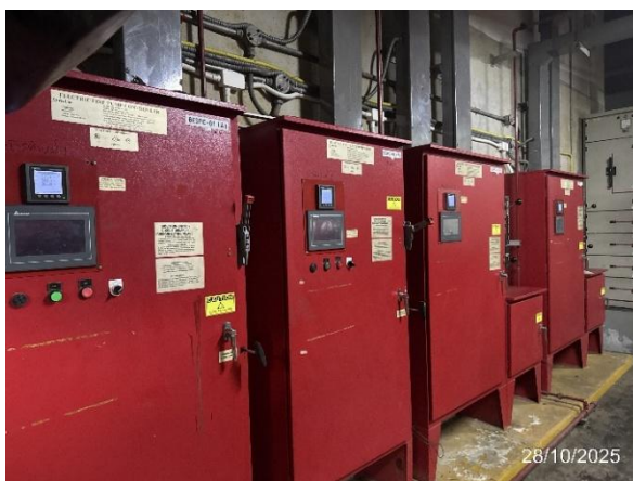
รูปที่ 2-7 เครื่องสูบน้ำดับเพลิงแบบขับเคลื่อนด้วยไฟฟ้า
