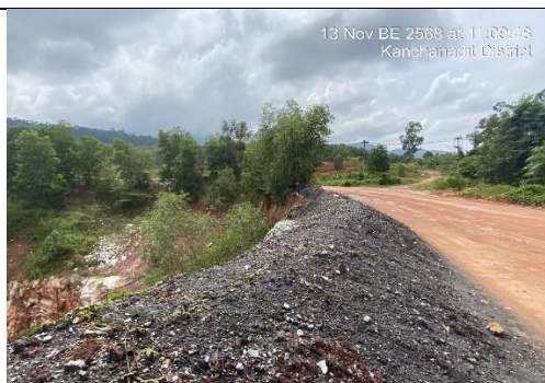
รูป 17 สร้างคันทำนบความกว้างฐาน 5 เมตร สูง 3 เมตร และสันคันด้านบนกว้าง 2.5 เมตรพร้อมปลูกพืชคลุมดิน
