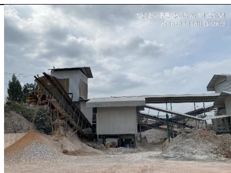
รูป 23 สร้างอาคารปิดคลุม Hopper, Primary Crusher และตระแกรงคัดขนาดแร่ พร้อมทั้งติดตั้งระบบสเปรย์น้ำ
