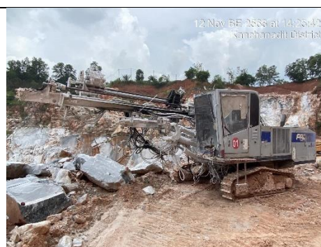
รูป 22 มีการใช้เครื่องเจาะรูระเบิดแบบ Hydraulic Crawler Drill
