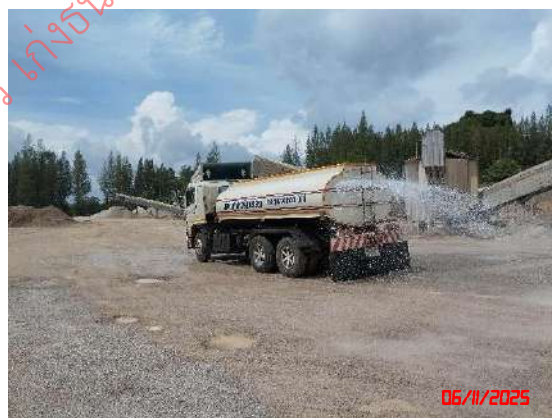
รูปที่ 11 การฉีดพรมน้ำเพื่อลดการฟุ้งกระจายของฝุ่นละออง
