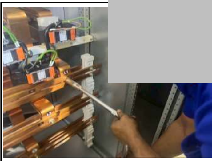
บำรุงรักษาและตรวจขันสกรู-น็อต Terminal Mainbusbar & Cable ต่างๆ ภายในตู้สวิตช์บอร์ด
