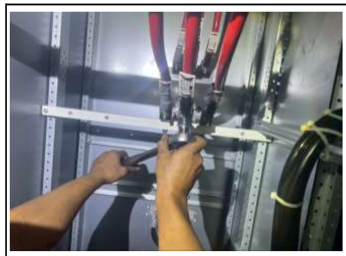
บำรุงรักษาและตรวจขันสกรู-น็อต Terminal Mainbusbar & Cable ต่างๆ ภายในตู้สวิตช์บอร์ด
