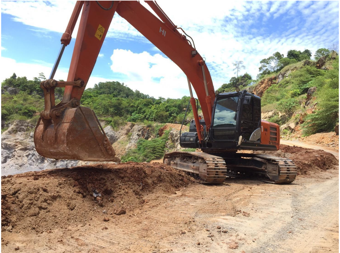
รูปภาพการทำแนวขอบเส้นทางขึ้น-ลง ป่อเหมือง
