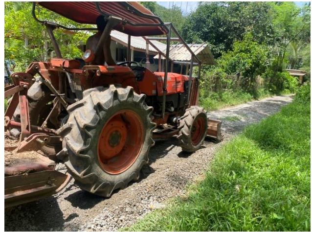
การปรับปรุงสภาพผิวถนนหลังการก่อสร้างแล้วเสร็จในพื้นที่ก่อสร้าง ของโครงการระบบโครงข่ายไฟฟ้า 500 กิโลโวลต์ พุ่งสง-สงขลา3
