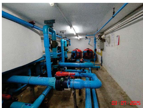
รูปที่ 12 ระบบสูบน้ำ
