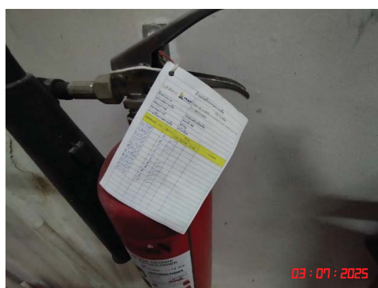
ถังดับเพลิงชนิดมือถือพร้อมแบบบันทึกการตรวจสภาพการใช้งาน
