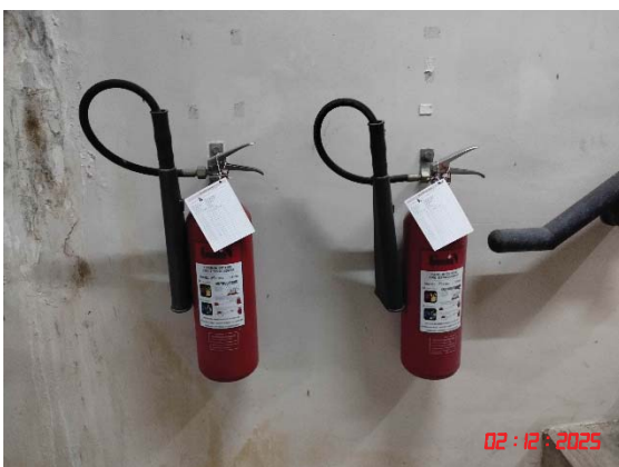
ถังดับเพลิงชนิดมือถือพร้อมแบบบันทึกการตรวจสภาพการใช้งาน
