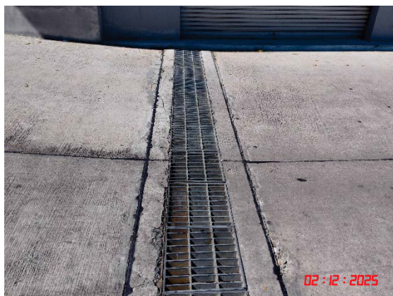
รูปที่ 11 รางระบายน้ำของโครงการ
