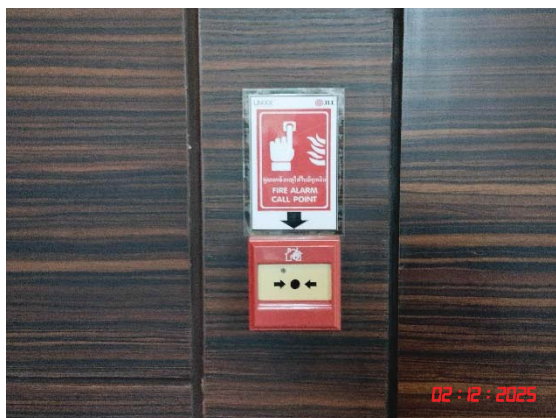
อุปกรณ์เตือนภัยด้วยมือ
