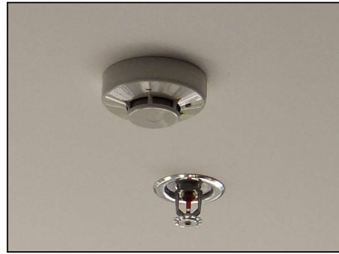
ภาพที่ 2-8 Smoke Detector & Sprinkler
