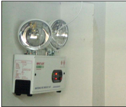
ภาพที่ 1-12 ไฟส่องสว่างฉุกเฉิน
