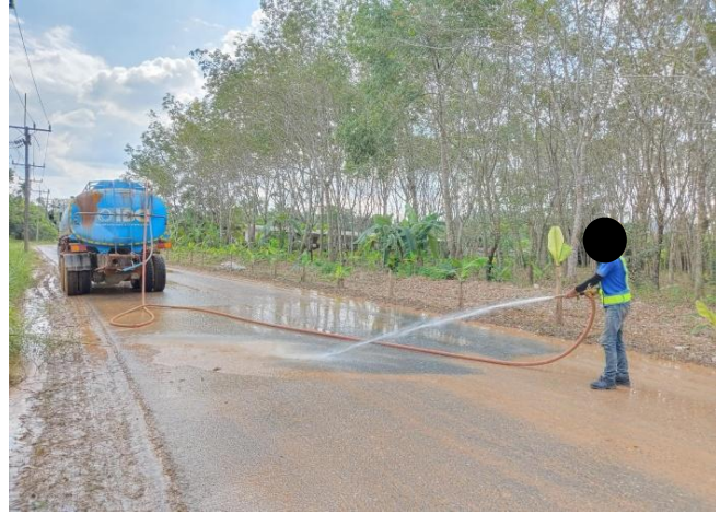
ภาพที่ 8 ฉีดพรมน้ำเส้นทางบรรทุกขนส่งแร่
