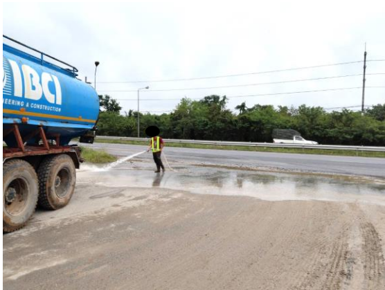
รูปที่ 12 การทำความสะอาดเก็บกวาดฝุ่นละอองที่ตกสะสมอยู่บนเส้นทางขนส่งแร่
