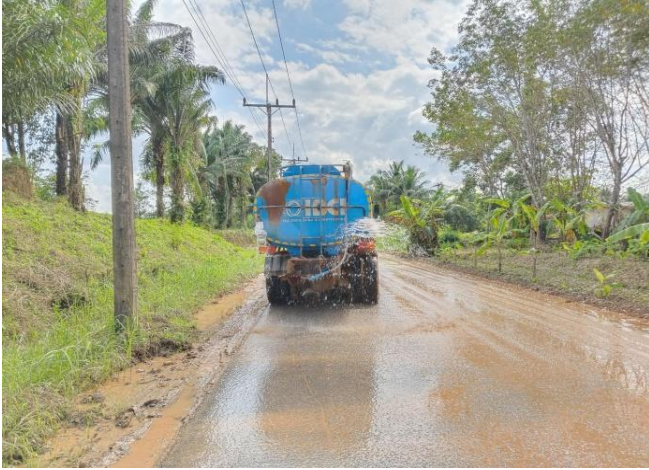
ภาพที่ 7 ฉีดพรมน้ำเส้นทางบรรทุกขนส่งแร่
