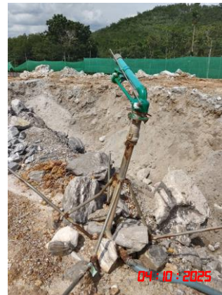
รูปที่ 9 การฉีดพรมน้ำบริเวณหน้าเหมืองและเส้นทางขนส่งแร่
