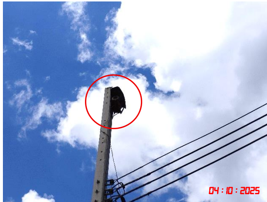
รูปที่ 15 เครื่องส่งสัญญาณเตือนก่อนการระเบิด
