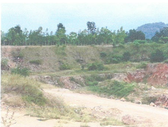
รูปที่ 8 นำเปลือกดินจากหน้าเหมืองมาสร้างคัน ทำนบกั้นรอบเขตประทานบัตรด้านทิศตะวันออก
