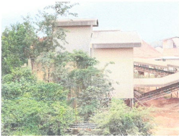
รูปที่ 13 การปิดคลุมอาคารโรงโม่หิน ชุด Hopper & Primary Crusher
