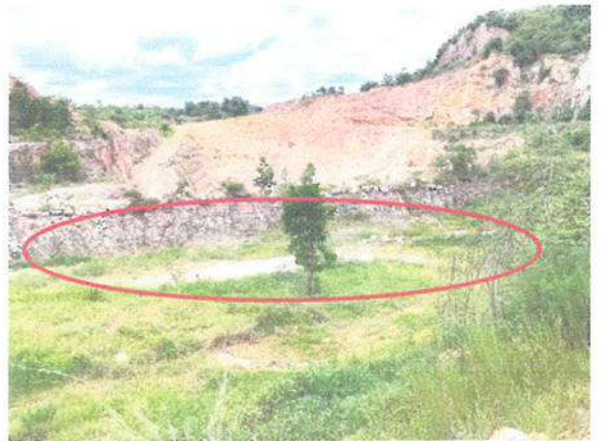
รูปที่ 5 บริเวณที่รองรับน้ำชั้นก่อนซึมลงสู่ชั้นใต้ดินไปรวมกับ Sump ของประธานบัตรข้างเคียง
