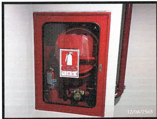
รูปที่ 3-20 ตู้เก็บสายฉีดน้ำดับเพลิงพร้อมอุปกรณ์
