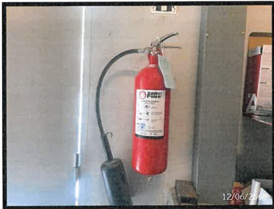
รูปที่ 3-19 ถังดับเพลิงเคมีแบบมือถือ
