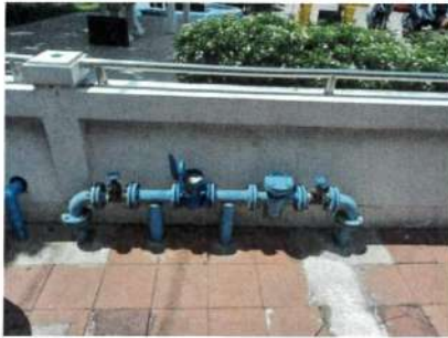
(ง) การติดตั้งมิเตอร์วัดปริมาณน้ำใช้ด้านหน้าโครงการ มีป้ายรณรงค์การใช้น้ำอย่างประหยัด
