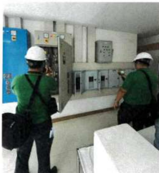
(ฉ) การตรวจสอบระบบไฟฟ้าโดยวิศวกรไฟฟ้าที่ได้รับอนุญาตภายในโรงพยาบาล และบำรุงรักษาหม้อแปลงไฟฟ้า
