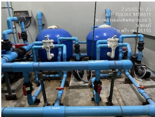
รูปที่ 24 ระบบปรับปรุงคุณภาพน้ำสระว่ายน้ำ
