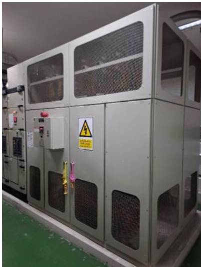
รูปที่ 3.5-5 หม้อแปลงไฟฟ้า
