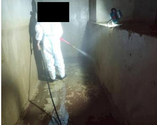
รูปที่ 3.1-3 การทำความสะอาดถังเก็บน้ำสำรอง
