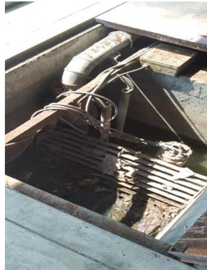
รูปที่ 3.3-4 ติดตั้งตะแกรงที่บ่อพักน้ำสุดท้ายของจุดระบายน้ำ
