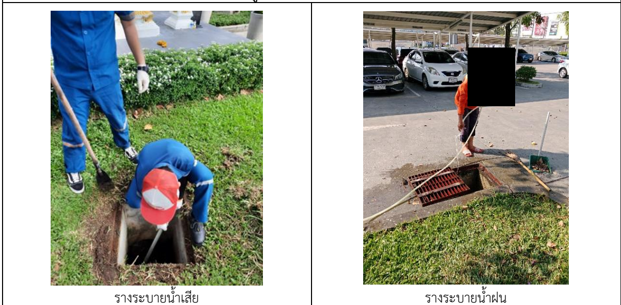
รูปที่ 3.3-2 การทำความสะอาดรางระบายน้ำ
