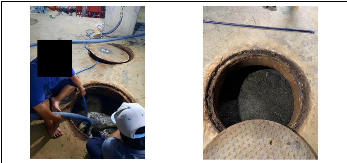
รูปที่ 3.2-2 การสุบปากตะกอน
