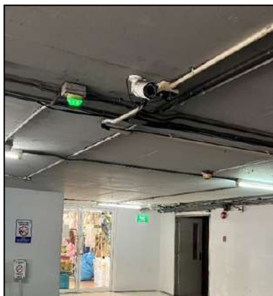
ภาพที่ 2-11 ระบบการตรวจนับช่องจอดรถในส่วนของ Plaza
