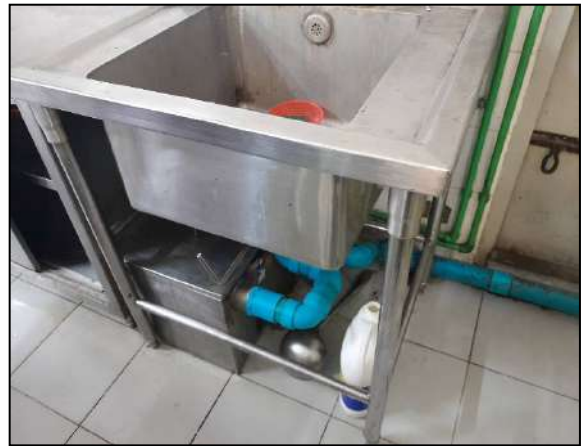
ภาพที่ 2-3 ถังดักไขมันรองรับน้ำเสียจากครัว/ร้านอาหารของโรงแรม
