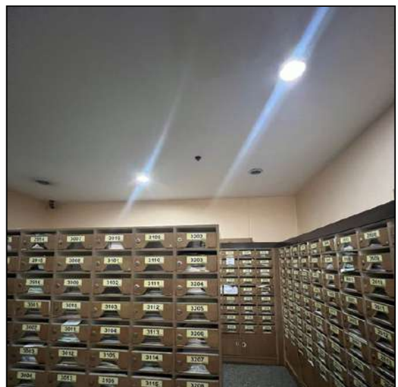
ภาพที่ 2-5 การเปลี่ยนมาใช้หลอดไฟ LED แทนหลอดตะเกียบ
