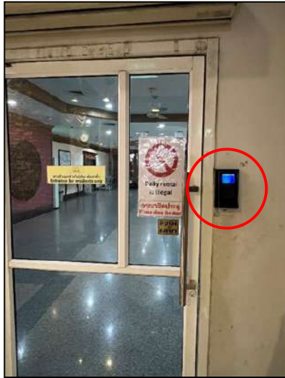
ภาพที่ 2-16 เครื่อง scan นิ้วมือที่ประตูทางเชื่อมระหว่าง Plaza และอาคาร B
