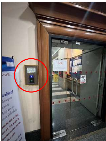
ภาพที่ 2-17 เครื่อง scan นิ้วมือบริเวณประตูทางเข้าโถงลิฟต์อาคาร B
