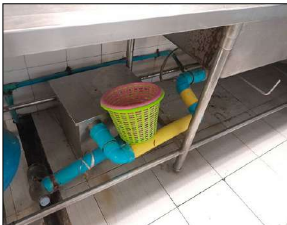
ภาพที่ 2-3 ถังดักไขมันรองรับน้ำเสียจากครัว/ร้านอาหารของโรงแรม
