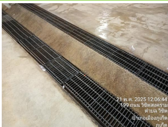
รูปที่ 3-27 ตะแกรงดักมูลฝอย
