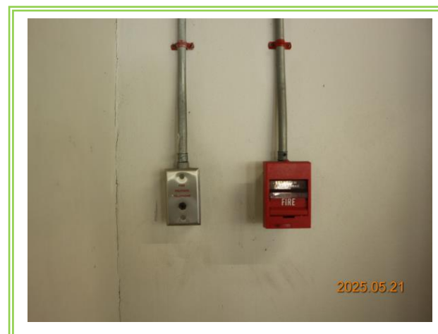
รูปที่ 3-49 อุปกรณ์แจ้งเหตุเพลิงไหม้แบบมือกด
