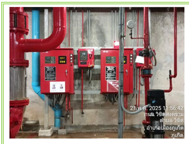
รูปที่ 3-58 ระบบปั๊มดับเพลิงอัตโนมัติ
