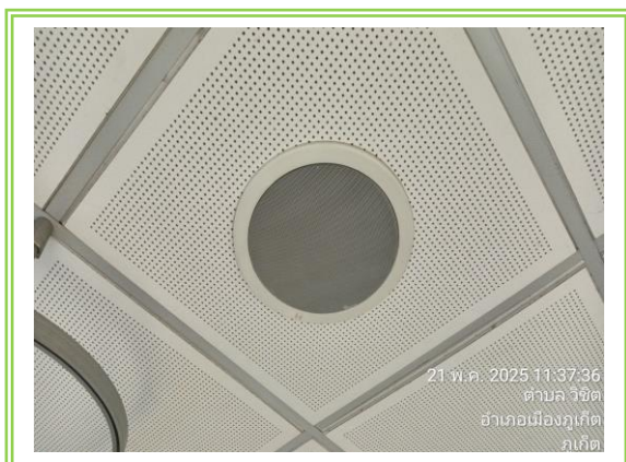
ลำโพงแจ้งสัญญาณเตือนเพลิงไหม้
