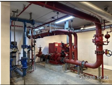
รูปที่ ผ7.40 เครื่องสูบน้ำดับเพลิง
