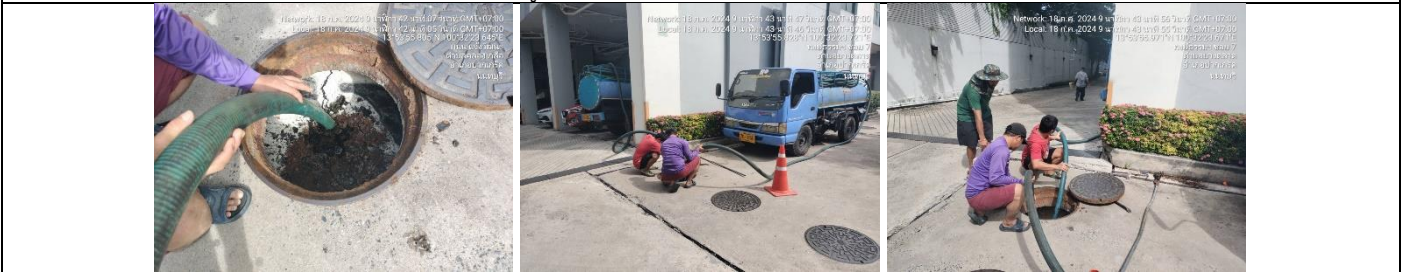
รูปที่ ผ7.46 การสูบน้ำออกจากระบบบำบัดน้ำเสีย (อาคาร B)
