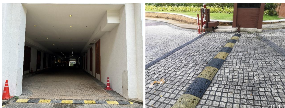
รูปที่ 3-21 อุปกรณ์ชะลอความเร็วของรถในโครงการ
