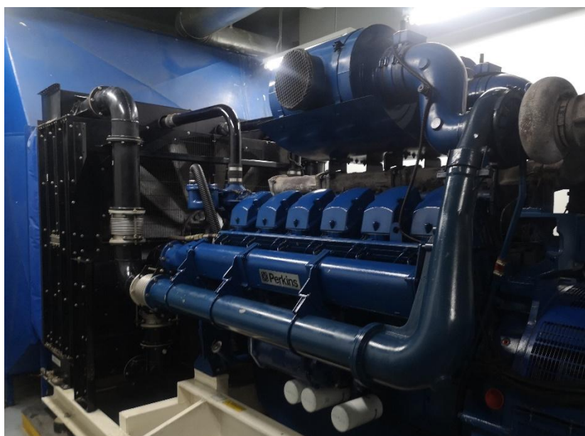
รูปที่ 3-15 เครื่องยนต์ผลิตไฟฟ้าสำรองใช้ดีเซล ขนาด 1,200 kW
