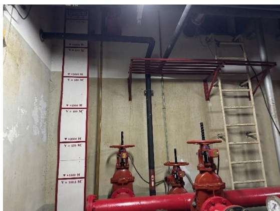
รูปที่ 3-10 ถังเก็บน้ำสำรอง เพื่อใช้เฉพาะในการดับเพลิง
