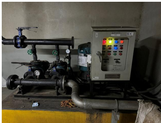
รูปที่ 3-12 เครื่องสูบน้ำหมุนเวียนกลับมาใช้ใหม่และถังเก็บน้ำหมุนเวียนกลับมาใช้ใหม่
