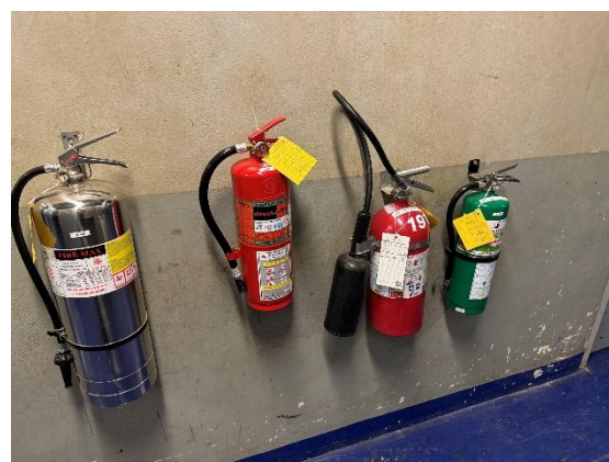
รูปที่ 3-8 อุปกรณ์ดับเพลิงและเครื่องดับเพลิงแบบมือถือ
