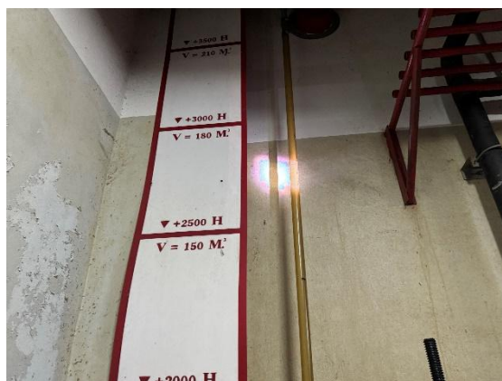
รูปที่ 3-10 ถังเก็บน้ำสำรอง เพื่อใช้เฉพาะในการดับเพลิง
