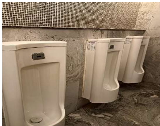
รูปที่ 2.11 สุขภัณฑ์ที่ประหยัดน้ำ และสามารถปรับระดับน้ำที่ใช้ได้ (วันที่ 9 มิ.ย. 2568)
