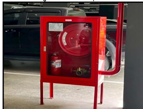
รูปที่ 2-38 ตู้ใส่อุปกรณ์ดับเพลิง
