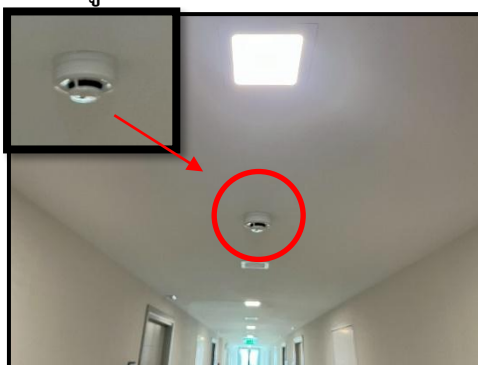
รูปที่ 2-39 เครื่องตรวจจับควัน
