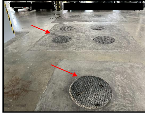
รูปที่ 2-10 ฝาล้างระบบบำบัดน้ำเสียเป็นฝาล้าง 2 ชั้น Double Seal
