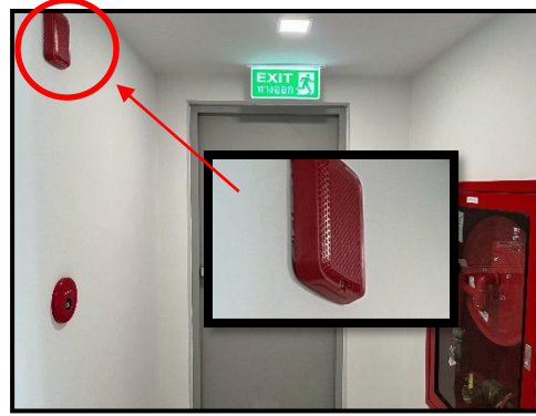
รูปที่ 2-42 เครื่องแจ้งเหตุด้วยเสียง
