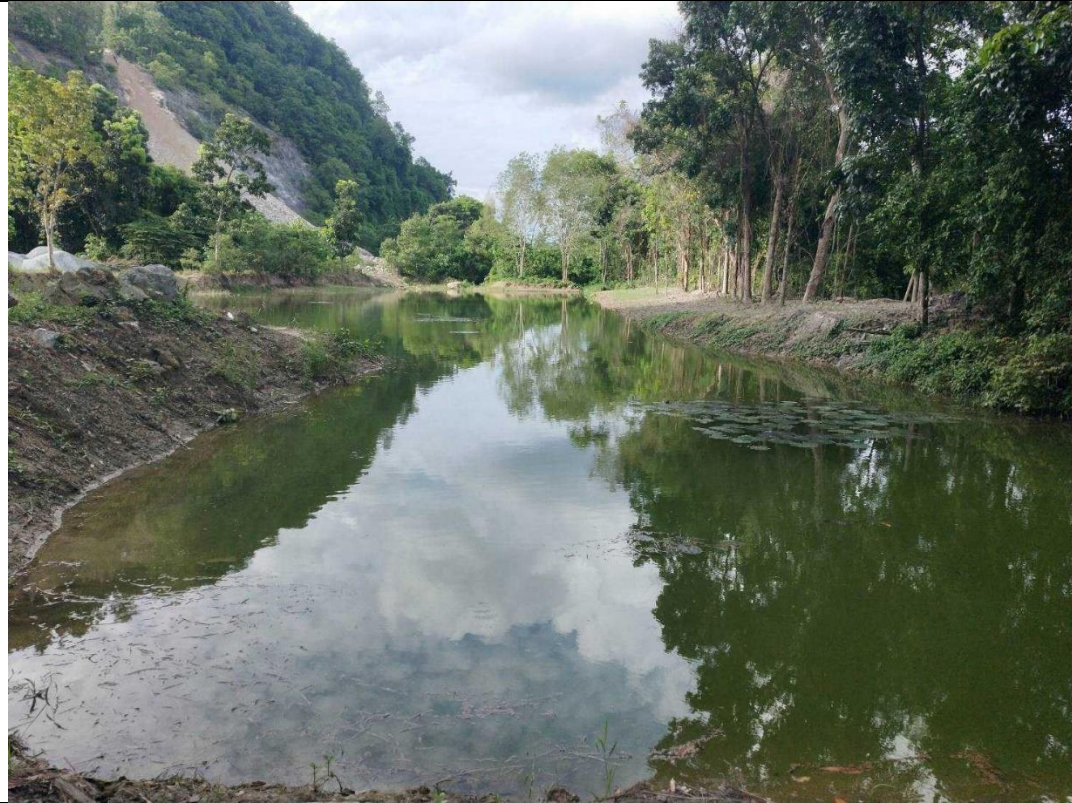
บ่อดักตะกอนที่ 2 หลังจากขุดลอกแล้ว
