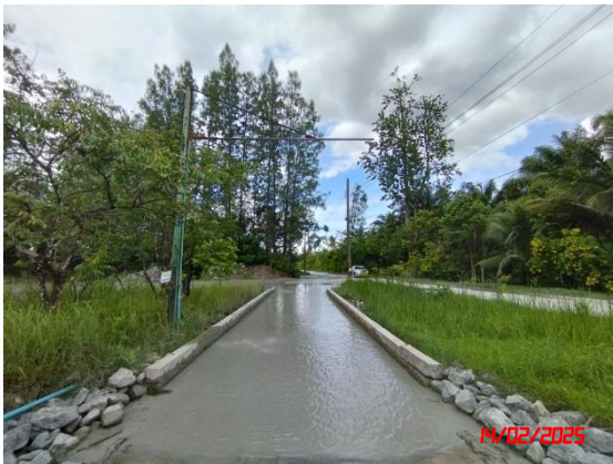
รูปที่ 13 ลานล้างล้อและระบบสปเรย์น้ำล้างล้อบริเวณพื้นที่โครงการ
