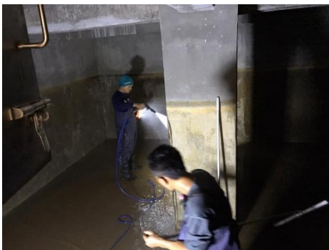
รูปที่ 2-15 การทำความสะอาดถังเก็บน้ำสำรอง
