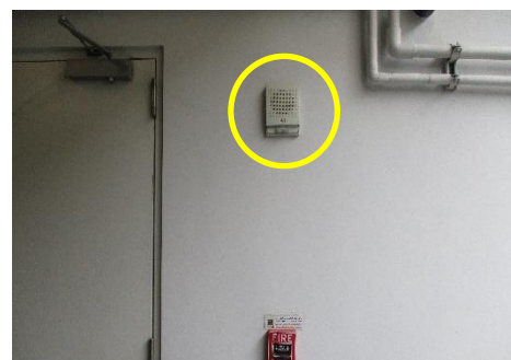
รูปที่ 2-26 สัญญาณเตือนเพลิงไหม้ (Alarm Bell)
