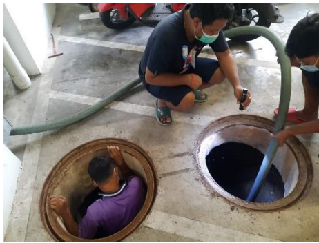
รูปที่ 2-13 การสูบล้างท่อระบายน้ำ
