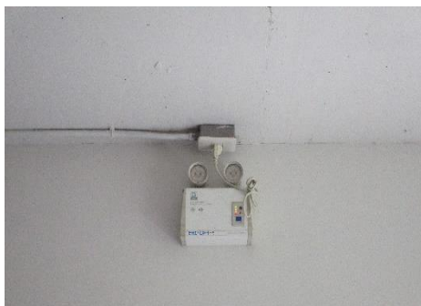
รูปที่ 2-35 ไฟส่องสว่างฉุกเฉิน (Emergency Light)
