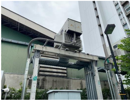
รูปที่ 2-46 อุปกรณ์เดินสายไฟฟ้าและสายสัญญาณไฟฟ้า สื่อสารตามมาตรฐานการไฟฟ้านครหลวง
