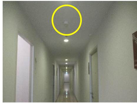
รูปที่ 2-28 เครื่องตรวจจับควัน (Smoke Detector)
