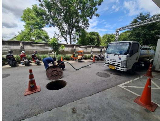
รูปที่ 2-13 การสูบน้ำจากบ่อน้ำบาดาล
