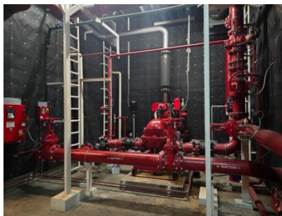
เครื่องสูบน้ำดับเพลิงชั้น 20-ชั้นดาตฟ้า
