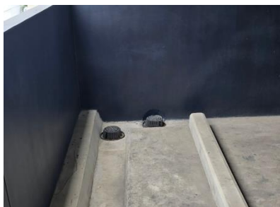
รางระบายน้ำมีตะแกรงครอบ
