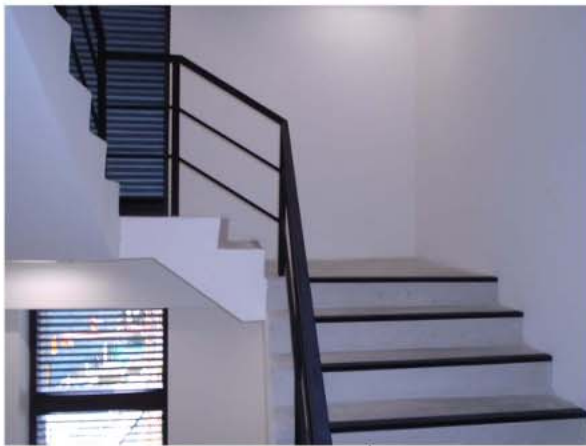
ภาพที่ 3-21 บันไดหนีไฟและช่องเปิดระบายอากาศแบบธรรมชาติ
