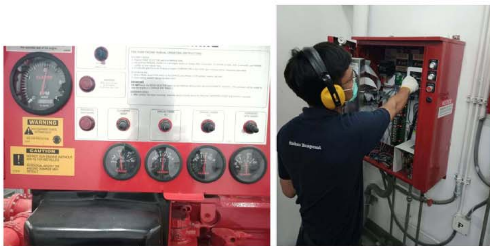
ภาพที่ 3-14 ห้องเครื่องดับเพลิง และการทดสอบประจำปี
