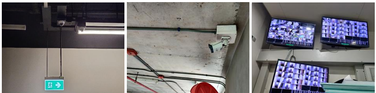
ภาพที่ 1.3.10-1 ระบบกล้องวงจรปิด (CCTV)
