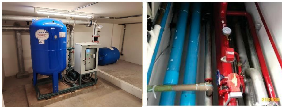
ภาพที่ 1.3.4-2 ถังเก็บน้ำชั้นดาดฟ้า และระบบปั๊ม
