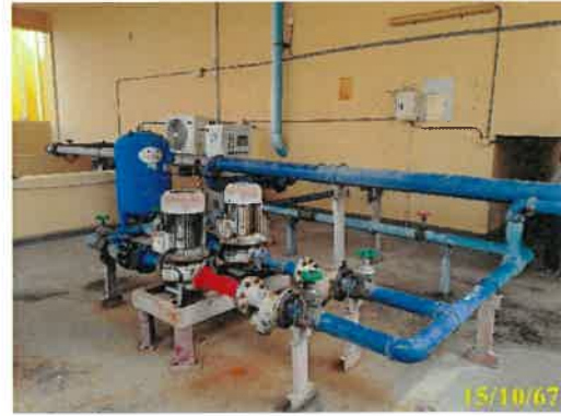
ถังเก็บน้ำคาดฟ้า พร้อมเครื่องปั้มน้ำอาคาร B
