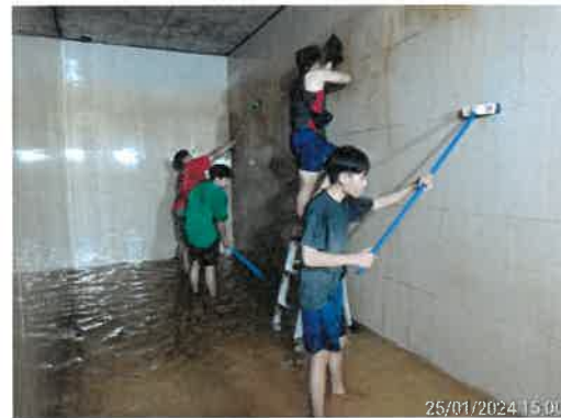
ล้างถังสำรองน้ำใช้พื้นที่โครงการเฟส 2 (25/01/67)
