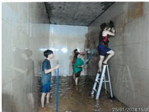
ล้างถังสำรองน้ำใช้พื้นที่โครงการเฟส 2 (25/01/67)
