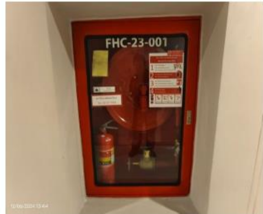
ภาพที่ 4 อุปกรณ์ดับเพลิง
