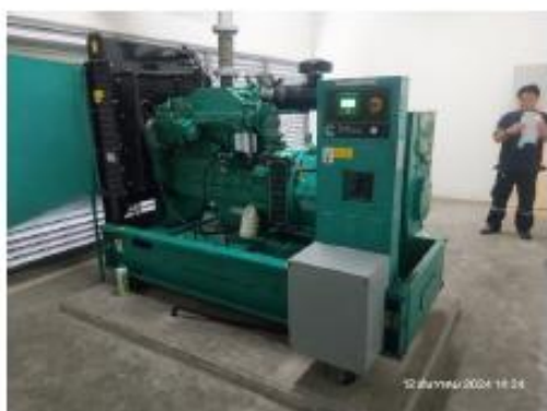
ภาพที่ 23 เครื่องกำเนิดไฟฟ้าสำรอง
