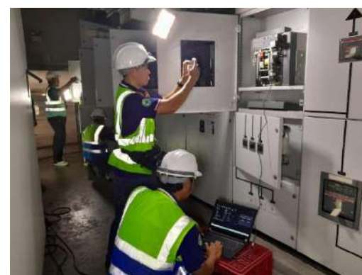
ภาพขณะทำการทดสอบ Air circuit breaker
