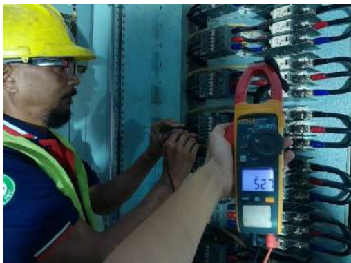
ภาพขณะทำการวัดค่า Capacitor Bank
