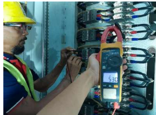
ภาพขณะทำการวัดค่า Capacitor Bank
