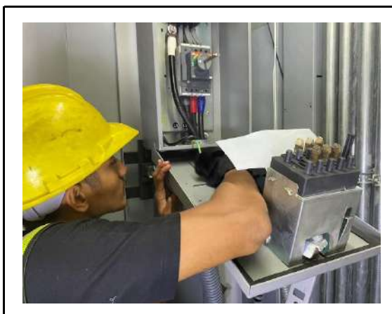
ภาพขณะทำการบำรุงรักษาตู้ Distribution Board & Load Panel
