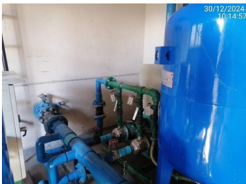
ภาพที่ 13 ตรวจสอบรอยรั่วของท่อจ่ายน้ำ
