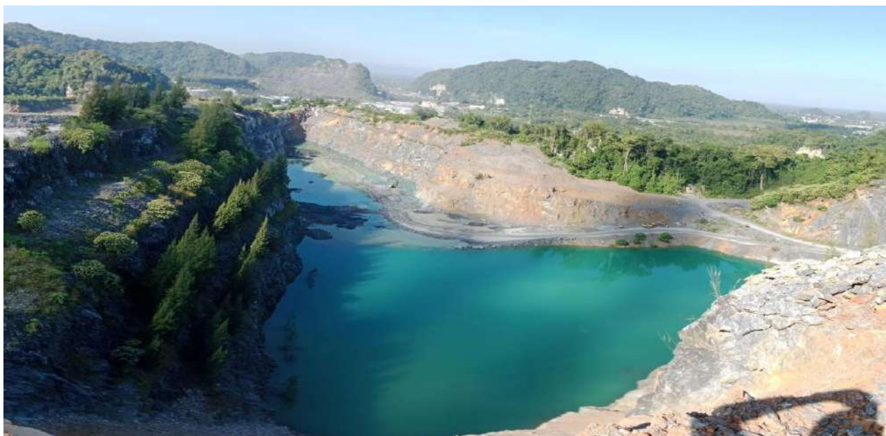
ชุมเหมืองเก่าใช้เป็นบ่อดักตะกอนเพื่อรองรับน้ำจากหน้าเหมืองช่วงหน้าฝน
