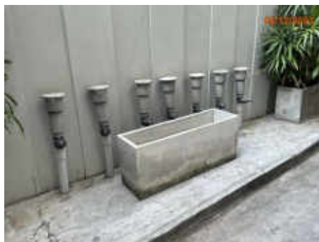
ระบบกำจัดก๊าซจากระบบบำบัดน้ำเสีย
