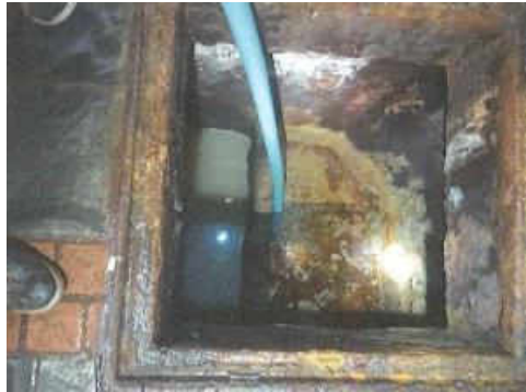
การสูบน้ำตะกอนในบ่อดักไขมัน
