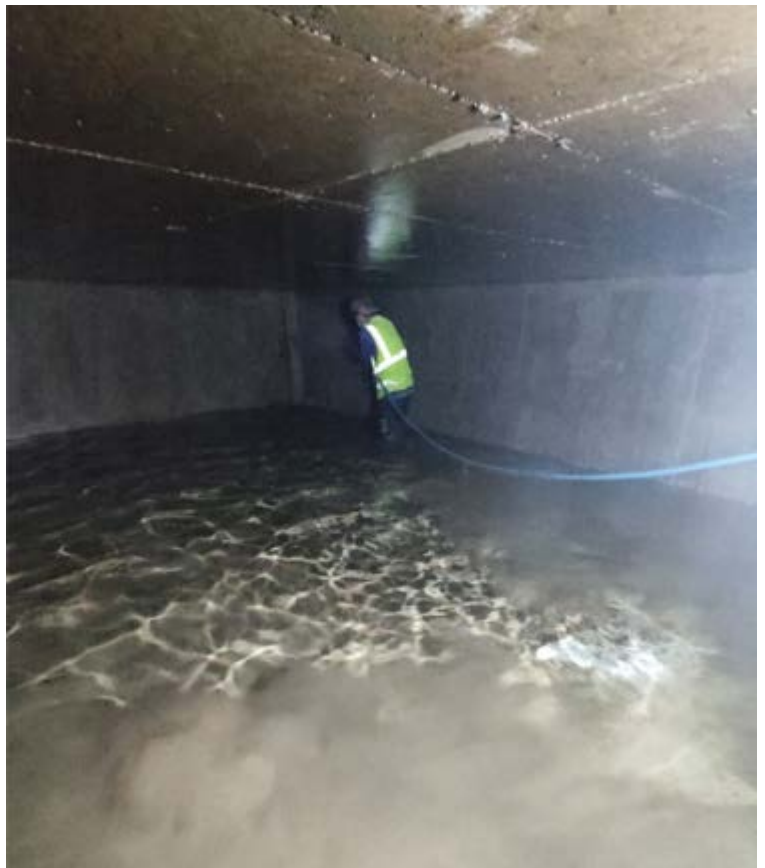
ภาพพนักงานใช้น้ำสะอาดฉีดล้างและขัดผนัง
