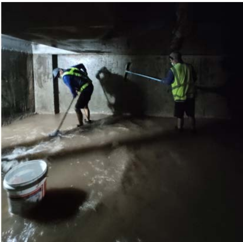
ภาพพนักงานกำลังขัดผนังถึงเก็บน้ำ
