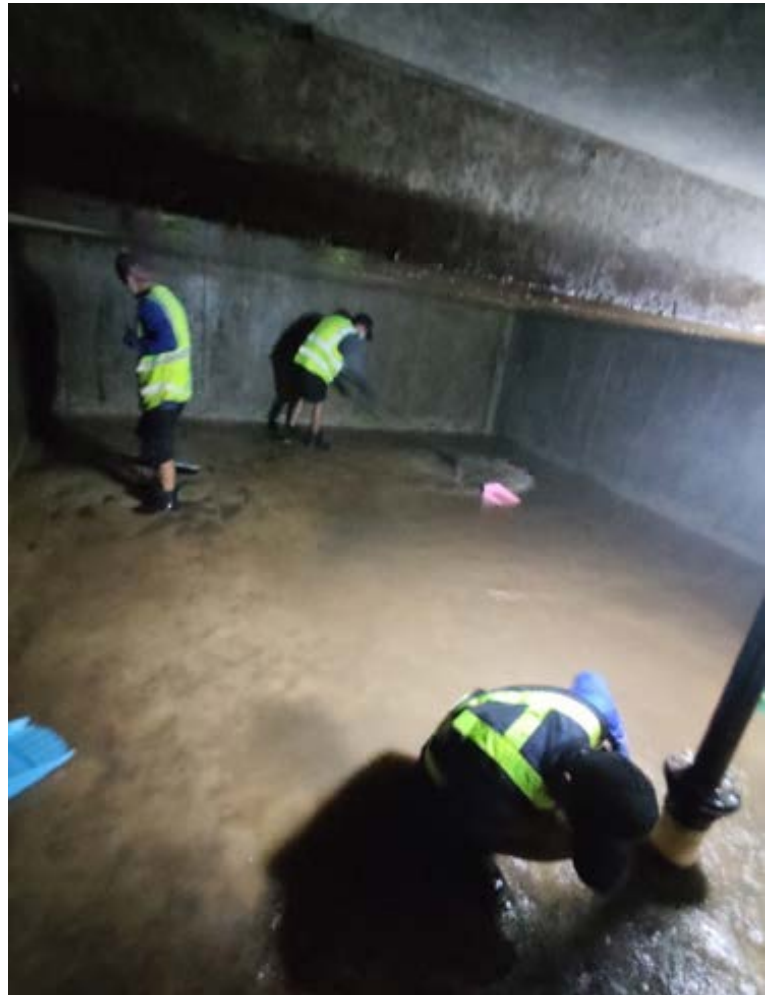
ภาพภายในถังน้ำ พนักงานทำการกวาดตะกอน
