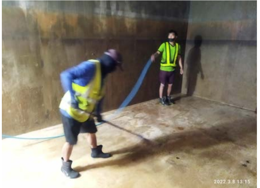
ภาพพนักงานฉีดน้ำล้างพื้นไล่ตะกอน
