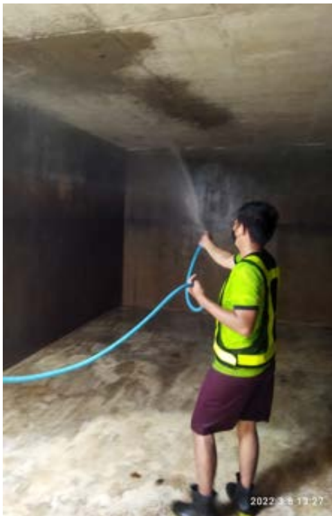
ภาพพนักงานฉีดคลอรีนทั่วถึง เพื่อฆ่าเชื้อโรค
