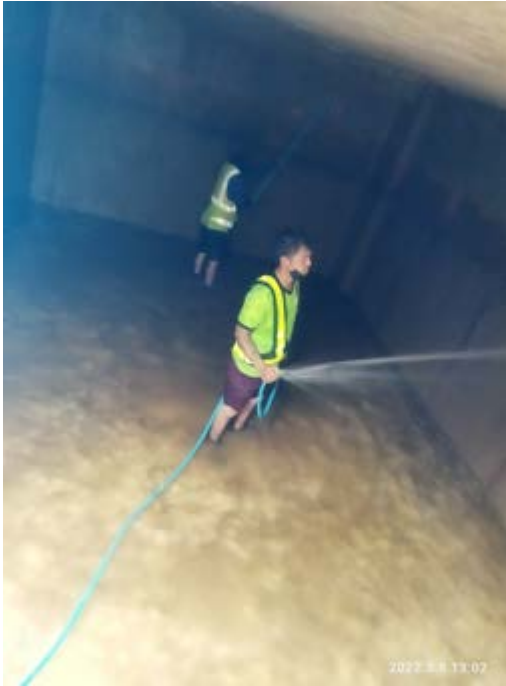
ภาพพนักงานทำการขัดผนังและฉีดน้ำสะอาดล่าง
