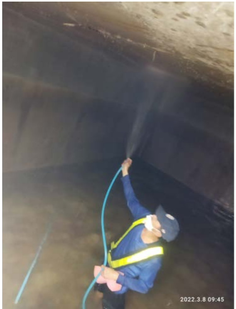
ภาพพนักงานใช้น้ำสะอาดฉีดล้างผนังและเพดานถึงน้ำ
