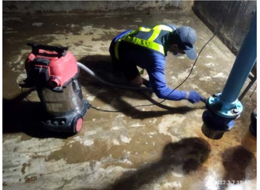
ภาพพนักงานทำการดูดตะกอนทรายออกให้หมด
