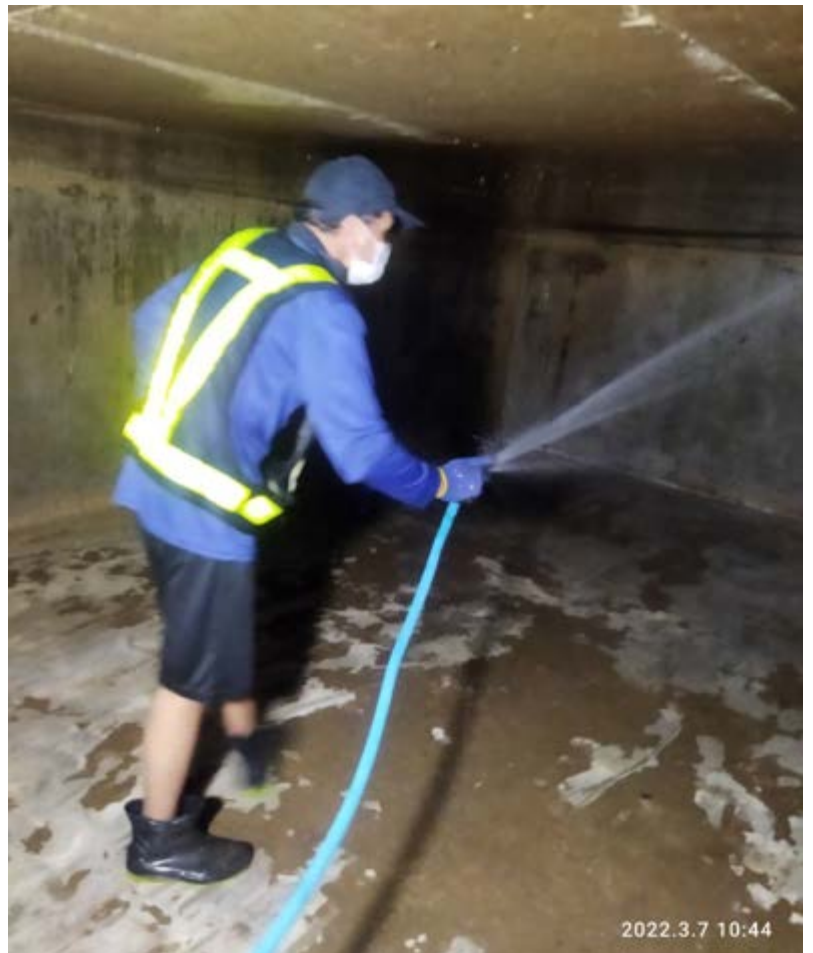
ภาพพนักงานทำการฉีดคลอรีนทั่วถึง เพื่อฆ่าเชื้อโรค
