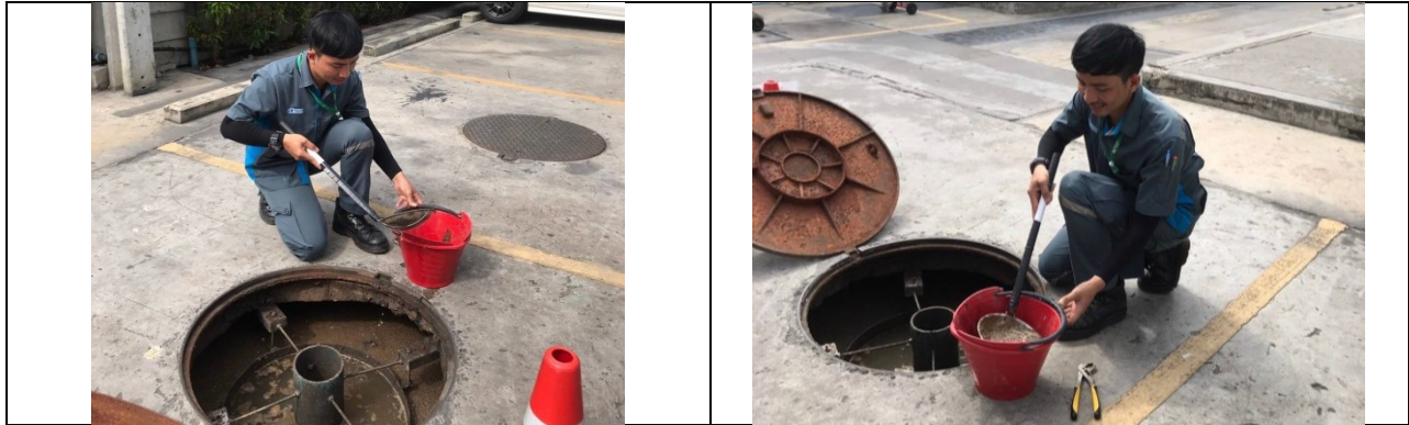
รูปที่ 2-9 การตักกากไขมันที่ถังดักไขมัน
