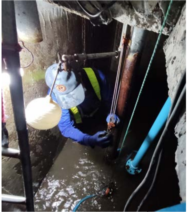
ภาพพนักงานทำความสะอาดก้นวัดระดับน้ำ
