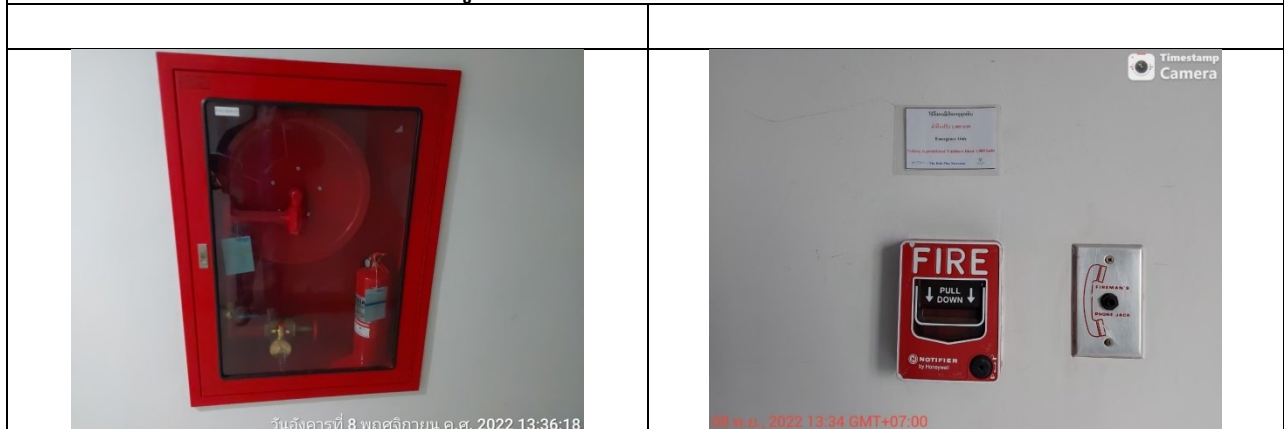
รูปที่ 2-20 ระบบป้องกันและระงับอัคคีภัย และระบบเตือนอัคคีภัย
