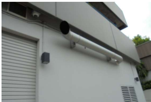
ภาพที่ 3-18 ท่อไอเสียจากห้องเครื่องกำเนิดไฟฟ้า
