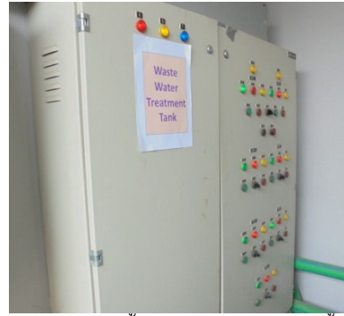
ภาพที่ 3-5 บริเวณบ่อบำบัดน้ำเสียรวม รางระบายน้ำรอบโครงการ ตู้คอนโทรลระบบบำบัดน้ำเสียและป้ายบอกจุดติดตั้งระบบบำบัดน้ำเสีย
