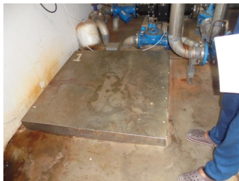
ภาพที่ 3-15 ถังสำรองน้ำใต้ดินและฝาถังสำรองน้ำ
