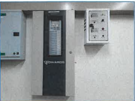
ภาพถ่ายที่ 2.2-25 ระบบแจ้งเตือนอัคคีภัยและป้องกันอัคคีภัยภายในโรงแรม
