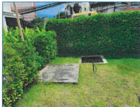
ภาพถ่ายที่ 2.2-15 บ่อพักน้ำพร้อมตะแกรงดักมูลฝอยก่อนระบายออกสู่สาธารณะ
