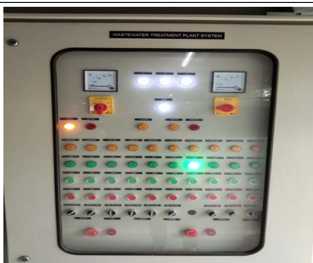
รูปที่ 2.5.1-3 ตู้ควบคุมระบบบำบัดน้ำเสีย
