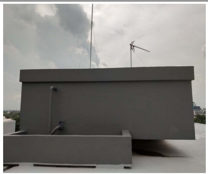
รูปที่ 2.4.1-2 ถังเก็บน้ำชั้นดาดฟ้า
