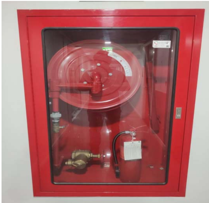
รูปที่ 2.6-3 เก็บบายน้ำดับเพลิงพร้อมอุปกรณ์
