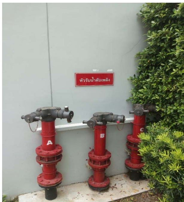
รูปที่ 2.6-1 หัวรับน้ำดับเพลิงภายนอกอาคาร
