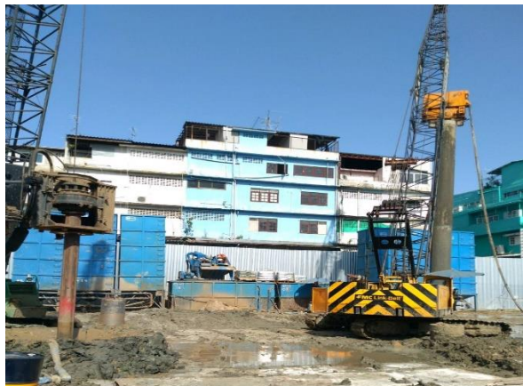
รูปที่ 2.49 การเจาะเสาเข็ม
