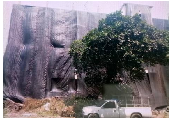
รูปที่ 2.4 ผ้าใบคลุมรอบอาคาร (รื้อถอน)
