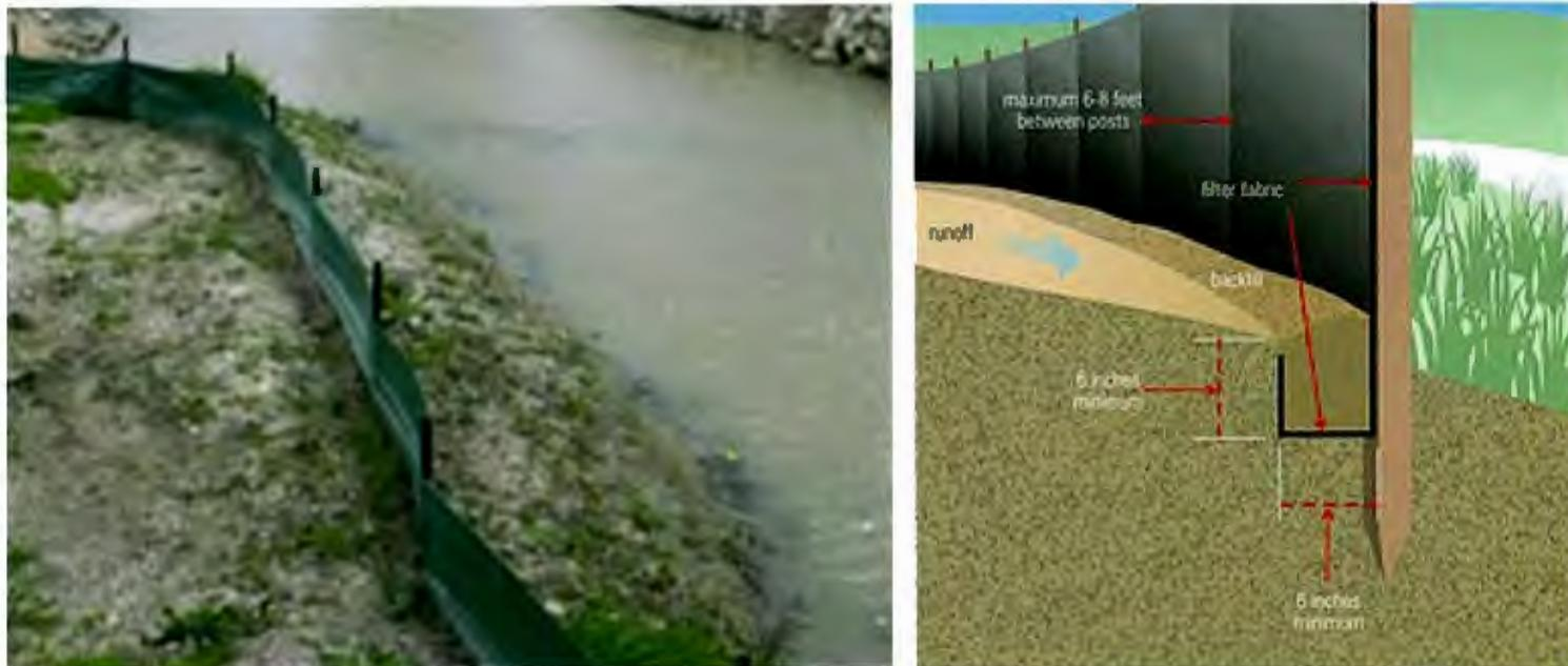
รูปที่ 1.1-1 การติดตั้งรั้วดักตะกอนแบบ Temporary Silt Fence
