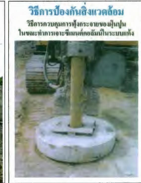
รูปที่ 1.3-1 วิธีการควบคุมการทุบกระเจาะของผู้รับเหมาในขณะทำการเจาะซึมมั่นต์กอลัมม์ในระบบแท้จ
