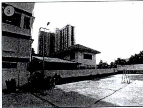
บ้านพักอาศัยสูง 2 ชั้น เลขที่ 640
