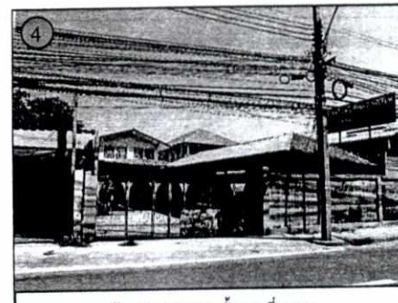
บ้านพักอาศัยสูง 2 ชั้น เลขที่ 25/1/1
