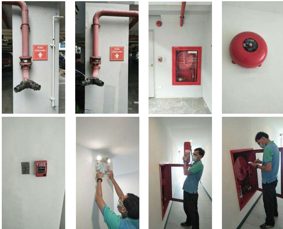
ภาพที่ 2-9 ภาพอุปกรณ์ระบบแจ้งเตือนเหตุเพลิงไหม้ ระบบดับเพลิง และการบำรุงรักษางานระบบ
