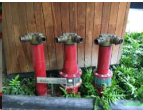
หัวรับน้ำดับเพลิงภายนอก ระบบป้องกันเพลิงไหม้
