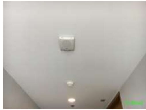
อุปกรณ์ส่งสัญญาณเพื่อให้หนีไฟอุปกรณ์แจ้งเหตุ
