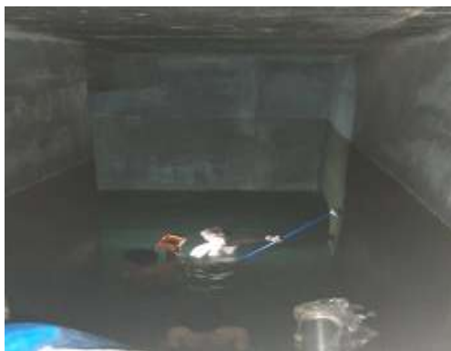
ภาพที่ 3.2-1 ทำความสะอาดถึงเก็บน้ำ
