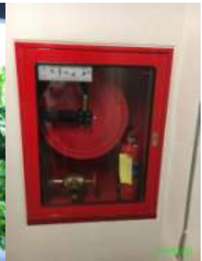
ตู้สายฉีดน้ำดับเพลิง
