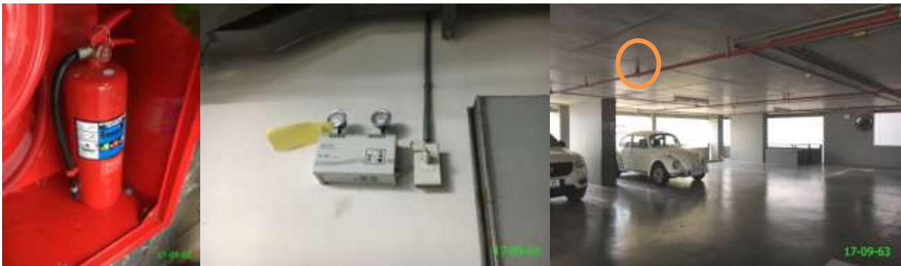
เครื่องดับเพลิงแบบมือถือ
