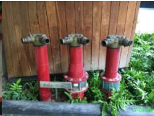
หัวรับน้ำดับเพลิงภายนอก ระบบป้องกันเพลิงไหม้
