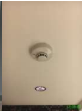
เครื่องตรวจจับความร้อน ระบบเตือนเพลิงไหม้
