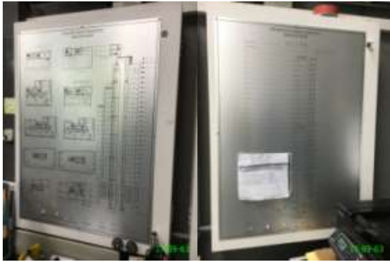
แผงควบคุมระบบสัญญาณแจ้งเหตุเพลิงไหม้
