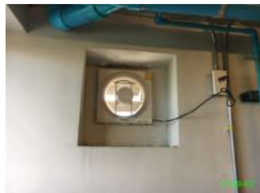
ระบายอากาศโดยใช้พัดลม
