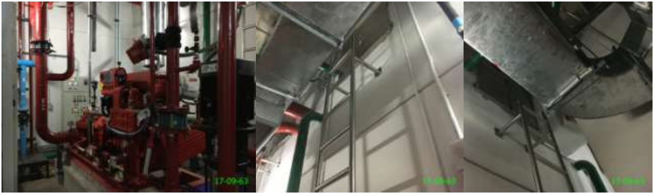
ปั้มน้ำและน้ำสำรองดับเพลิง ระบบป้องกันอัคคีภัย
