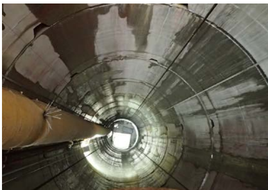
รูปที่ 2-59 การสร้างอุโมงค์ส่วนล่างที่อยู่ใน ชั้นเกลือ ให้มีขนาดกว้างอย่างน้อย 4 เมตร
