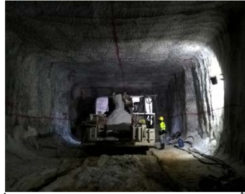
รูปที่ 2-62 การก่อสร้างช่องแวงเก็บหางแร่ในชั้น เกลือหิน (Backfill Panel)
