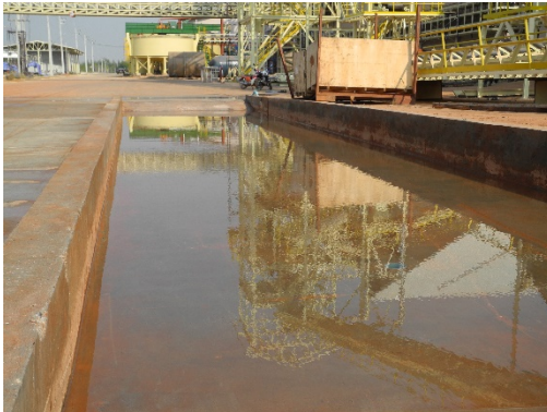
รูปที่ 2-27 ระบบการทำความสะอาดล้อรถบรรทุกที่ ออกจากพื้นที่โครงการ และพื้นที่ก่อสร้าง
