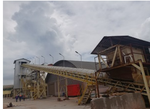
รูปที่ 2-54 ดำเนินการติดตั้งระบบสายพานลำเลียง บริเวณปากอุโมงค์แนวเอียง
