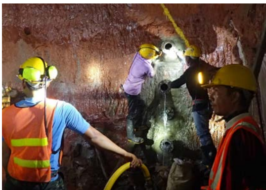
รูปที่ 2-65 เจาะหลุม และทำการอัดฉีดซีเมนต์จาก ภายในอุโมงค์เพื่อปิดผนึกชั้นน้ำใต้ดิน (Grouting) ก่อนการเจาะอุโมงค์ทุกครั้ง
