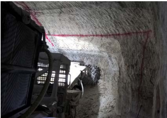
รูปที่ 2-57 รถขุดเจาะอุโมงค์ (Road header)
