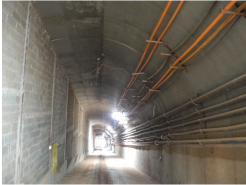
รูปที่ 2-55 ก่อสร้างผนังและหลังคาอุโมงค์ ด้วยคอนกรีตเสริมเหล็ก เหล็กยึดหินและคอนกรีต เสริมใยไฟเบอร์
