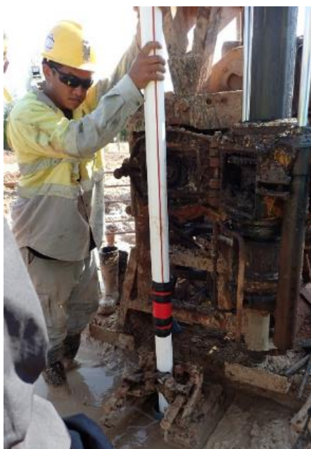
รูปที่ 3.7-11 หลุมตรวจวัดการเคลื่อนตัวของมวลดินในแนวราบบริเวณพื้นที่ก่อสร้างอุโมงค์แนวลาดและอุโมงค์แนวตั้ง
