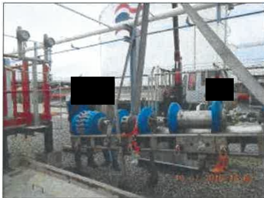
รูปที่ 2-3 การส่ง Intelligent Pig เพื่อตรวจสอบการรั่วของท่อส่งน้ำมันใต้ดิน
