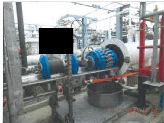
รูปที่ 2-3 การส่ง Intelligent Pig เพื่อตรวจสอบการรั่วของท่อส่งน้ำมันใต้ดิน
